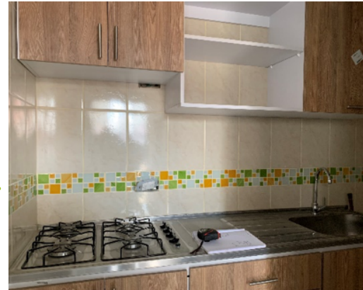
Mejoramiento de vivienda en Suba Fuente: Subdirección de Operaciones – SDHT
