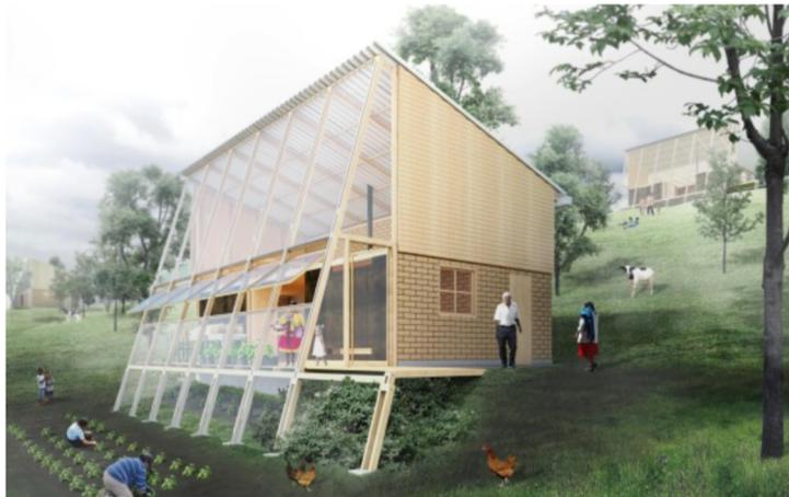
Este es el aspecto que tendría el prototipo de vivienda rural. Entre sus características destacan la reutilización de residuos orgánicos para compostaje y una cubierta de 60 m<sup>2</sup> que recolectaría hasta 9.1 m<sup>3</sup> de aguas de lluvia al mes. FOTO CORTESÍA FP ARQUITECTURA
