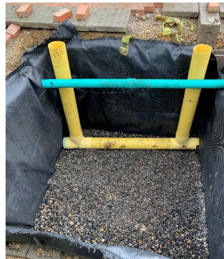
Construcción de contenedor de raíces , instalación de tuberías verticales, llenado de capas de drenaje
