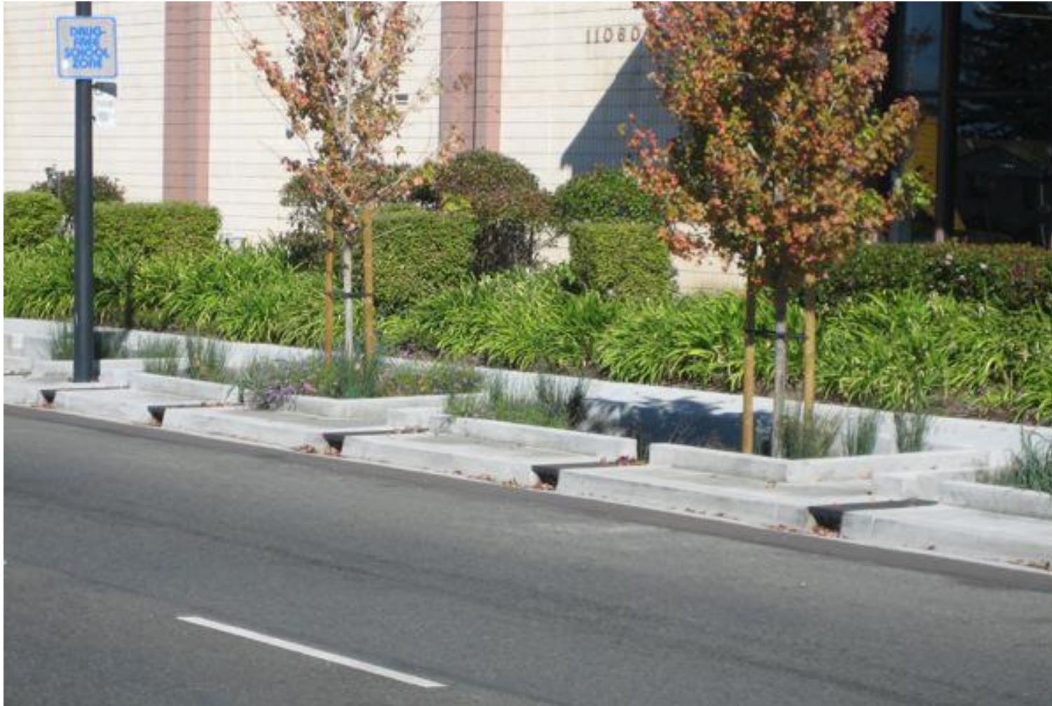
Aperturas en bordillos para ingreso de escorrentía
