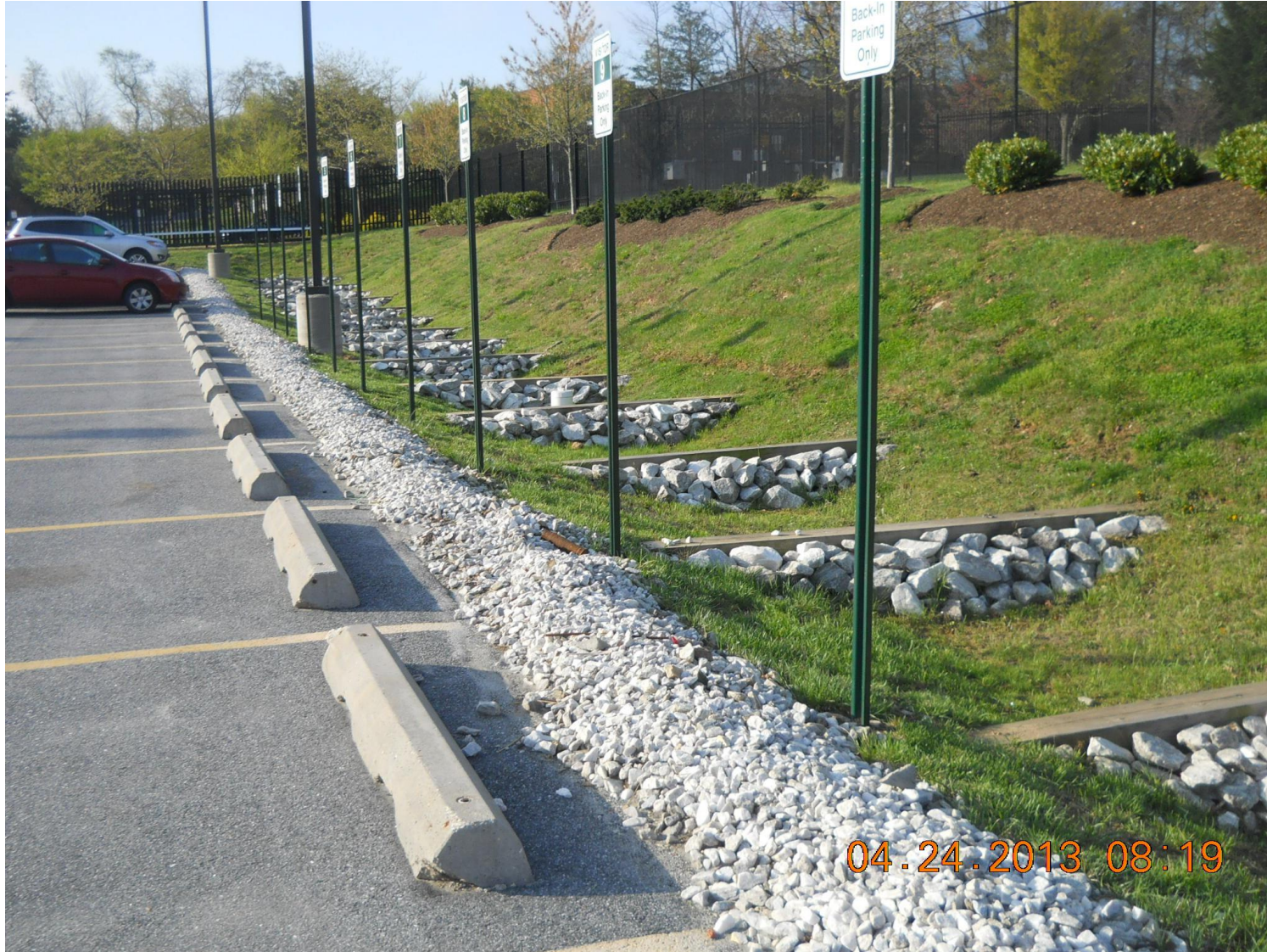
Barreras de detención
