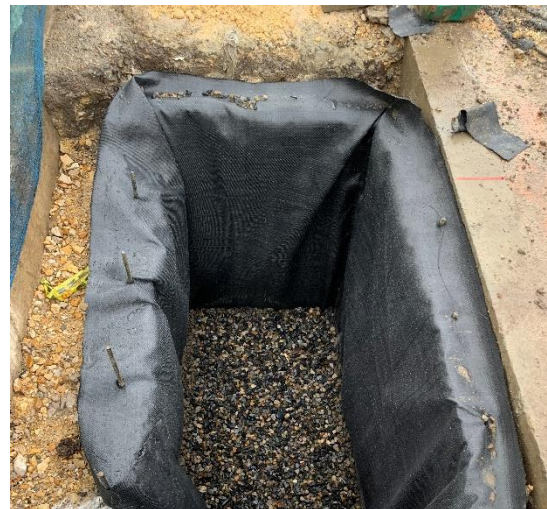
Construcción de contenedor de raíces , instalación de tuberías verticales, llenado de capas de drenaje
