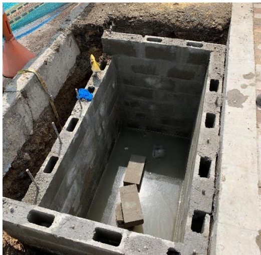
Construcción de contenedor de raíces , instalación de tuberías verticales, llenado de capas de drenaje
