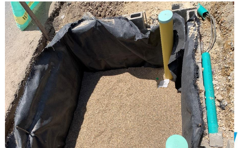
Construcción de contenedor de raíces , instalación de tuberías verticales, llenado de capas de drenaje
